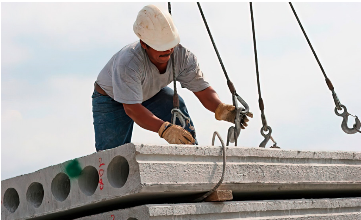
Das Vollzugsorgan SUVA wird ab dem 1. April 2023 auf Baustellen prüfen, ob die Personen, die Lasten anschlagen, über die notwendige Ausbildung verfügen!
